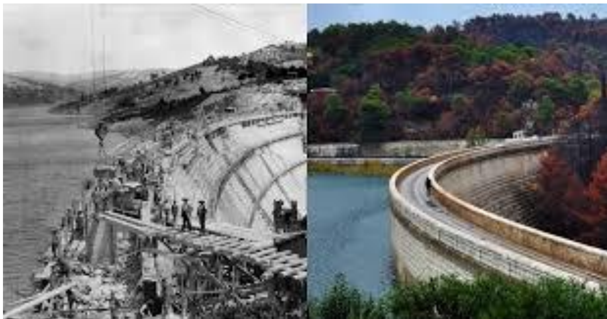
Εικόνα 1. Λίμνη - Τεχνητό Φράγμα Μαραθώνος
